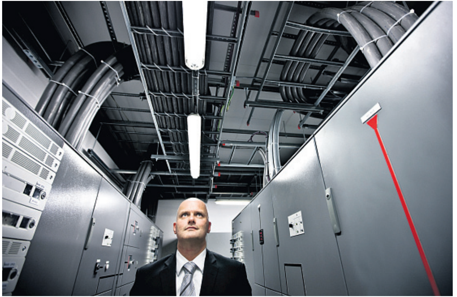
Chris Galenkamp van ICTroom in een datacenter waar onder meer het digitale verkeer van de fiscus doorheen loopt. Foto: Roger Dohmen
